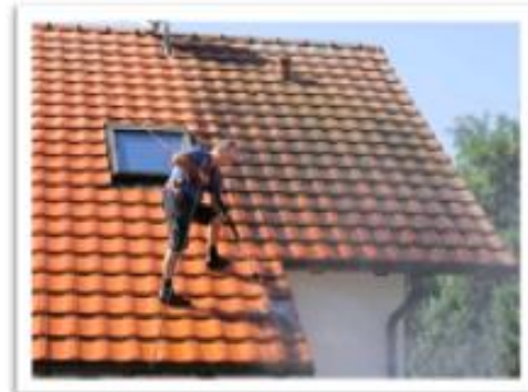
Opération de nettoyage et démoussage
