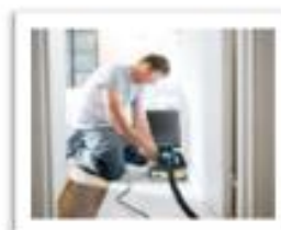
Détalonnage de porte
